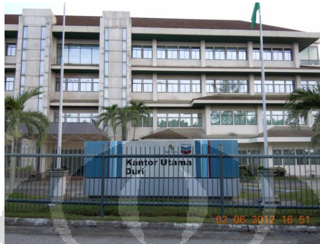
Gambar V.4.1.4 Pagar pada Gedung Main Office
