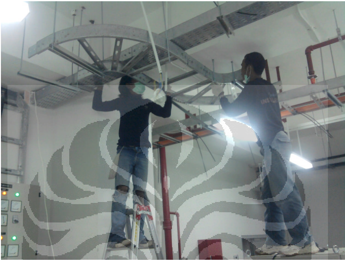
Lampiran 2. Foto pada proses pemasangan leader dan tray
