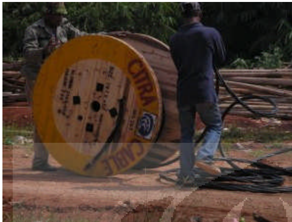
Lampiran 5. Foto pada proses pemasangan kabel pada instalasi battery
