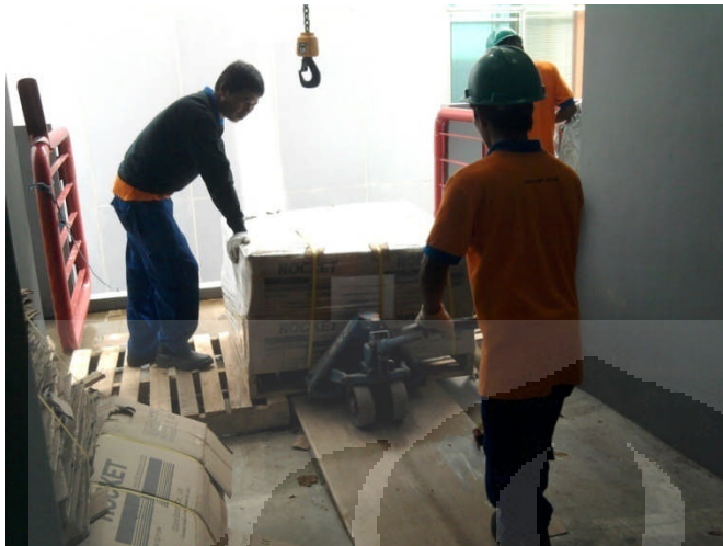
Lampiran 4. Foto pada proses pemasangan dan instalasi battery
