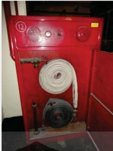
Gambar 6.20 Isi Kotak Hidran
