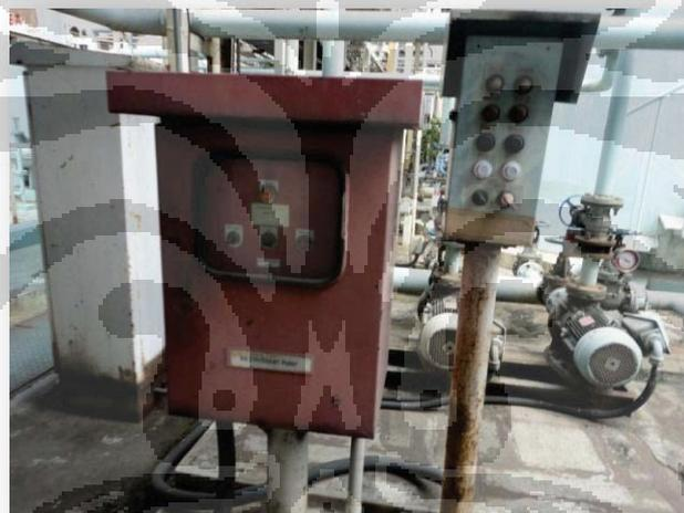
Gambar 6.15 Tombol Hidran dan Pompa Hidran
