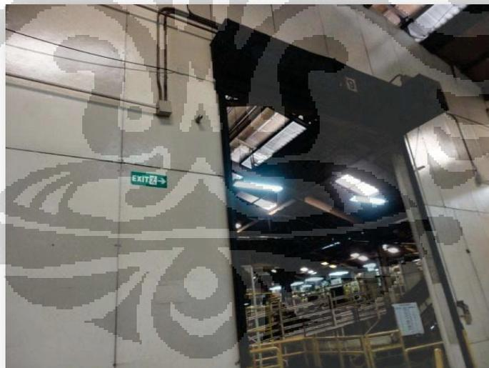
Gambar 6.12 Dinding dan Pintu Tahan Api di *Factory I*, PT. Bridgestone Tire Indonesia
