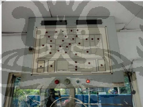
Gambar 6.3 *Control Panel Emergency System* yang terdapat di Ruang Pusat Pengendali Kebakaran (Ruang *Security*)
