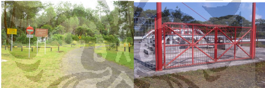
Gambar 5.40 Pintu Pagar Sebagai Kontrol Akses Mekanis yang Terpasang di dalam Wilayah Jalur Pipa dan Sumur
