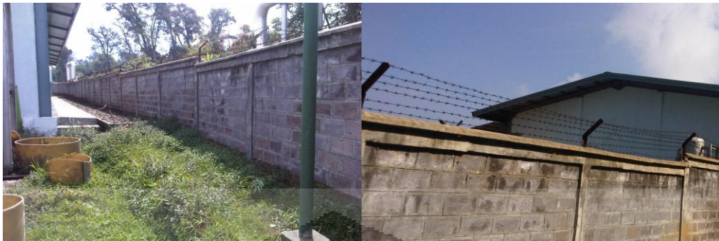
Gambar 5.21 Pagar yang Terpasang Pada Bagian Belakang Wilayah Workshop
