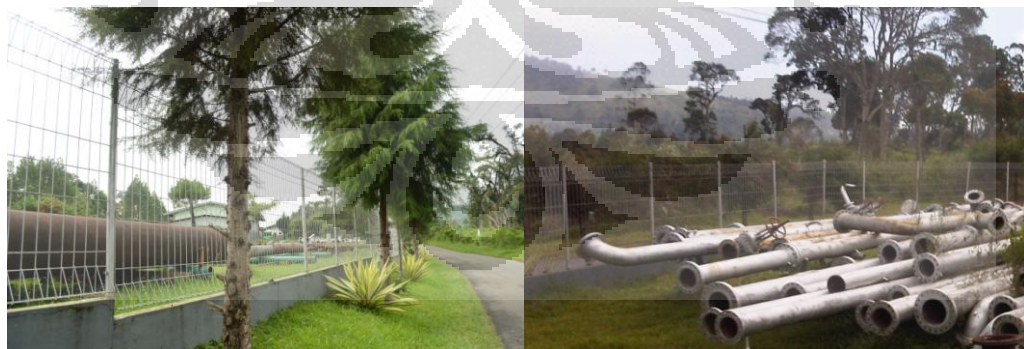
Gambar 5.22 Pagar yang Terpasang Pada Bagian Depan Wilayah Workshop
