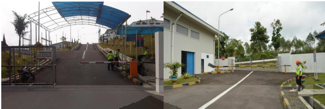
Gambar 5.30 Pintu Gerbang Sebagai Kontrol Akses Mekanis di Wilayah PLTP
