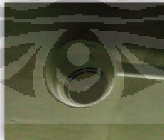
Gambar 6.3 Detektor Asap Gedung Perpustakaan Pusat Universitas Indonesia
