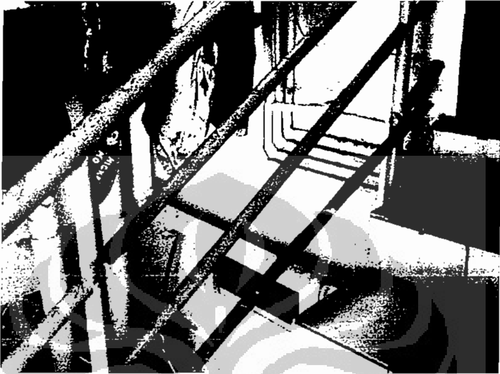
Foto 5. Adjustment Pengaman Tangga yang Rusak Diganti dengan Bambu
