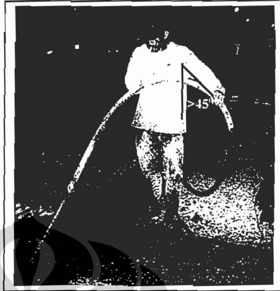
Gambar 5.6 - Kegiatan memberi getaran pada beton
