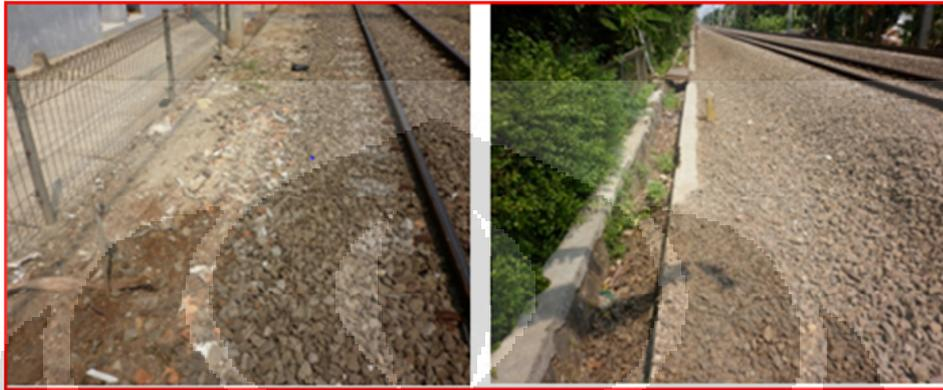
Gambar 4.11 Tidak ada Saluran Drainase (kiri) dan Saluran Drainase (kanan)
