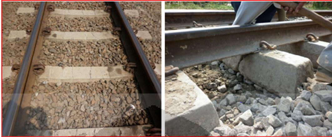
Gambar 4.15 Gambaran Bantalan Retak (Kiri) dan Gambar Bantalan Patah (Kanan)
