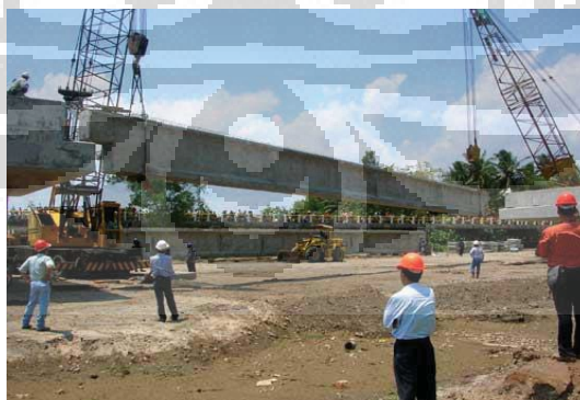
Gambar 2.10 Erection Dengan Menggunakan Crane
