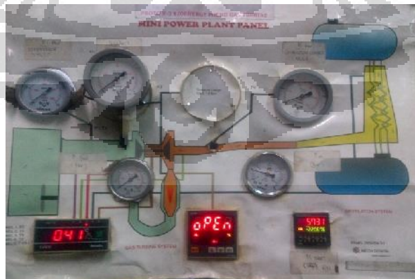
Gambar 3.8 Posisi pressure gauge, digital temperature, dan tachometer pada panel
