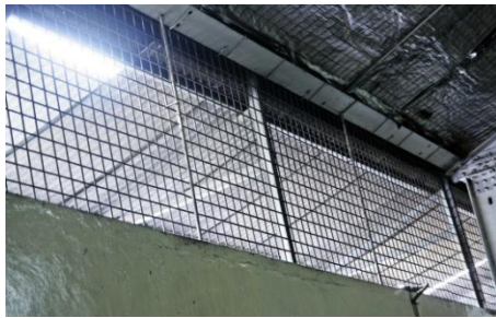
Gambar 6.3. Ventilasi Tralis Besi
