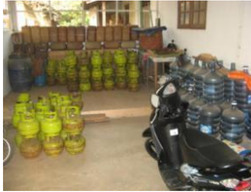
Gambar 5.41. Area Penyimpanan LPG Belum Bebas dari Bahan Mudah Terbakar
