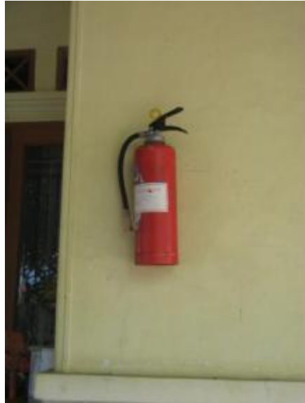
Gambar 5.45. Alat Pemadam Api Ringan Jenis Dry Chemical Powder
