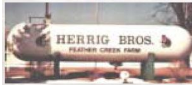
Gambar 5.1. Tangki Propana Milik Herrig Bros yang Terbakar dan Meledak di Iowa, AS, Tahun 1998
