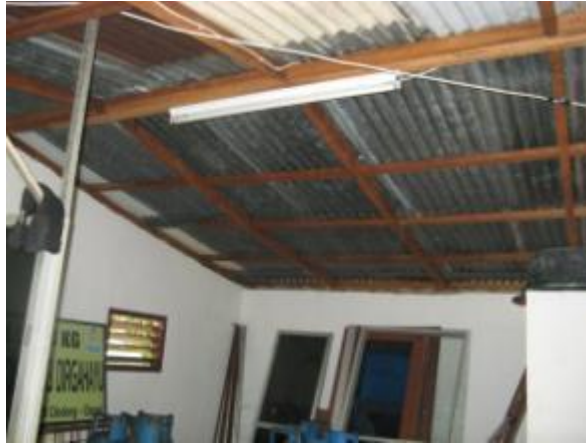
Gambar 5.43. Lampu Penerangan di Area Penyimpanan Jenis Fluorescence Biasa
