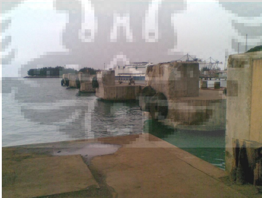
Gambar 4.6 Fender pada Dermaga 4 Pelabuhan Merak (Sumber: Foto Survey Pelabuhan Merak)
