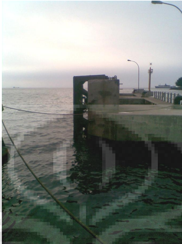
Gambar 4.7 Fender pada Dermaga 5 Pelabuhan Merak (Sumber: Foto Survey Pelabuhan Merak)
