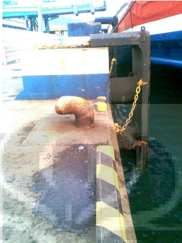
Gambar 4.5 Fender Dermaga 3 Nomor 1 (Sumber: Foto Survey Pelabuhan Merak)
