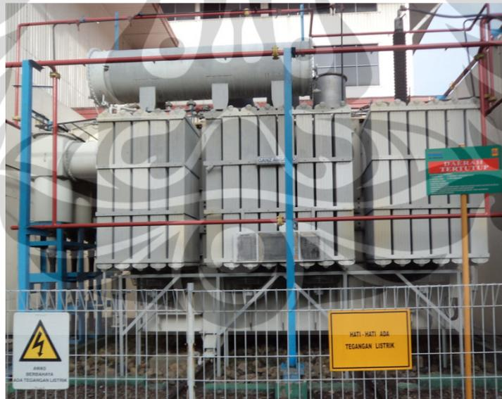
Gambar 3.11. Trafo utama (*main transformer*) dengan tipe ONAN
