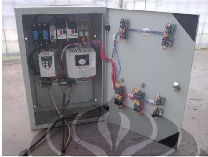
Gambar 3.9 *Control panel* yang digunakan untuk feeder dan blower
