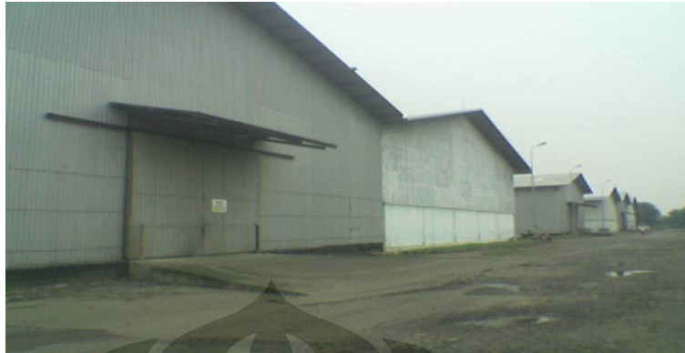
Komplek Gudang Divre DKI Jaya Sunter
