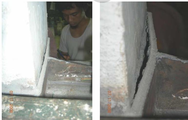
Gambar 5.1 Pelat pada Kolom arah Balok yang Lepas (Model-3)
