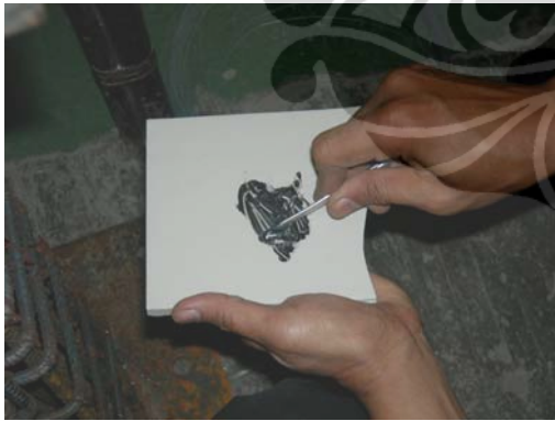
Gambar L32. Pengadukan Epoxy
