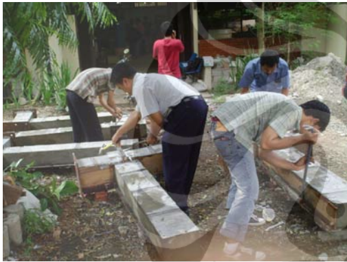
Gambar L59. Pembongkaran Bekisting
