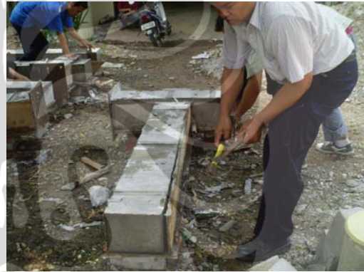
Gambar L60. Pembongkaran Bekisting
