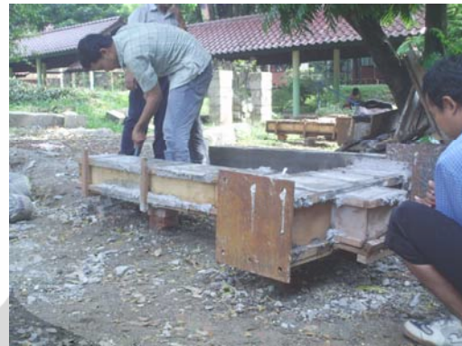
Gambar L58. Pembongkaran Bekisting
