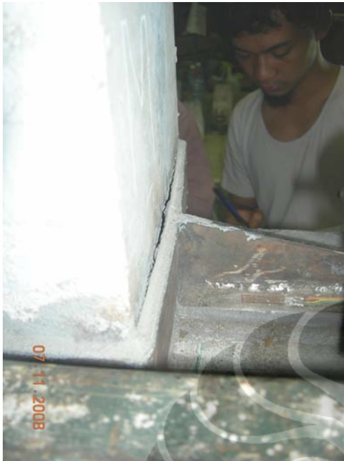
Gambar L113. Pelat Arah Kolom Lepas
