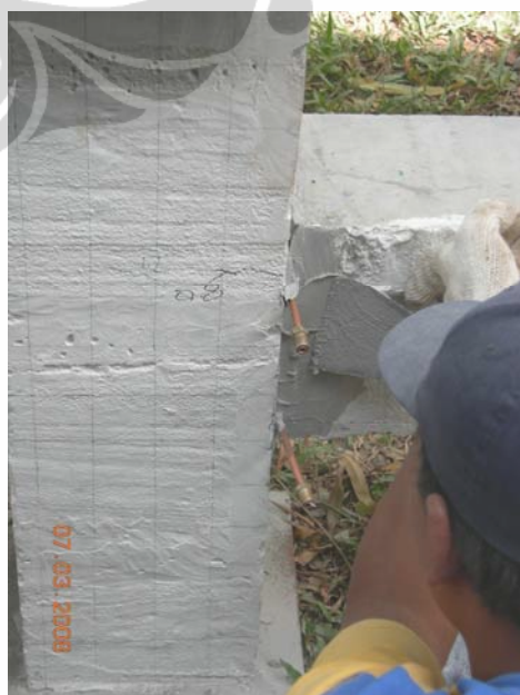
Gambar L85. Pasang pipa injeksi
