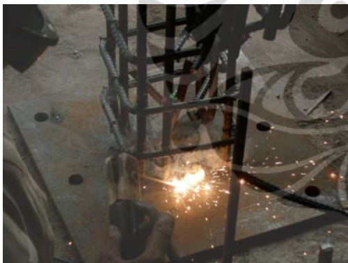
Gambar L19. Pengelasan Tulangan-Pelat
