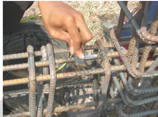
Gambar L23. Pengamplasan Tulangan
