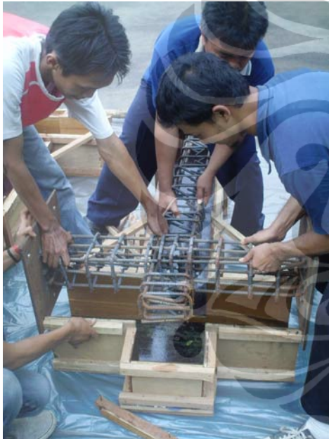
Gambar L37. Penempatan Tulangan
