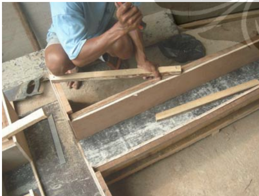
Gambar L5. Pemasangan Bekisting
