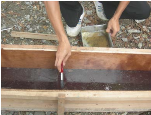
Gambar L35. Pengolesan Olie
