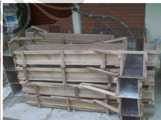
Gambar L6. Bekisting
