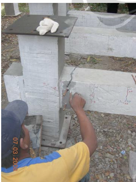
Gambar L84. Pasang pipa injeksi
