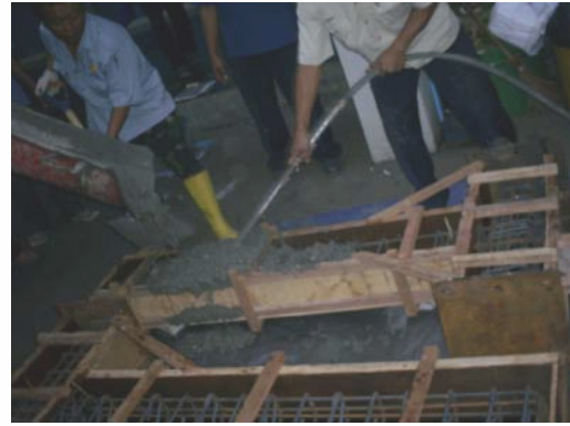
Gambar L48. Pengecoran
