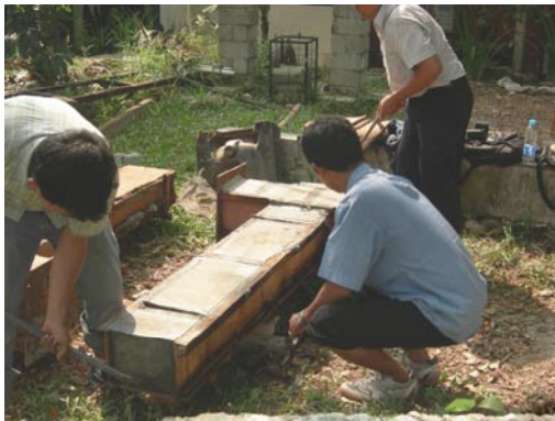
Gambar L57. Pembongkaran Bekisting
