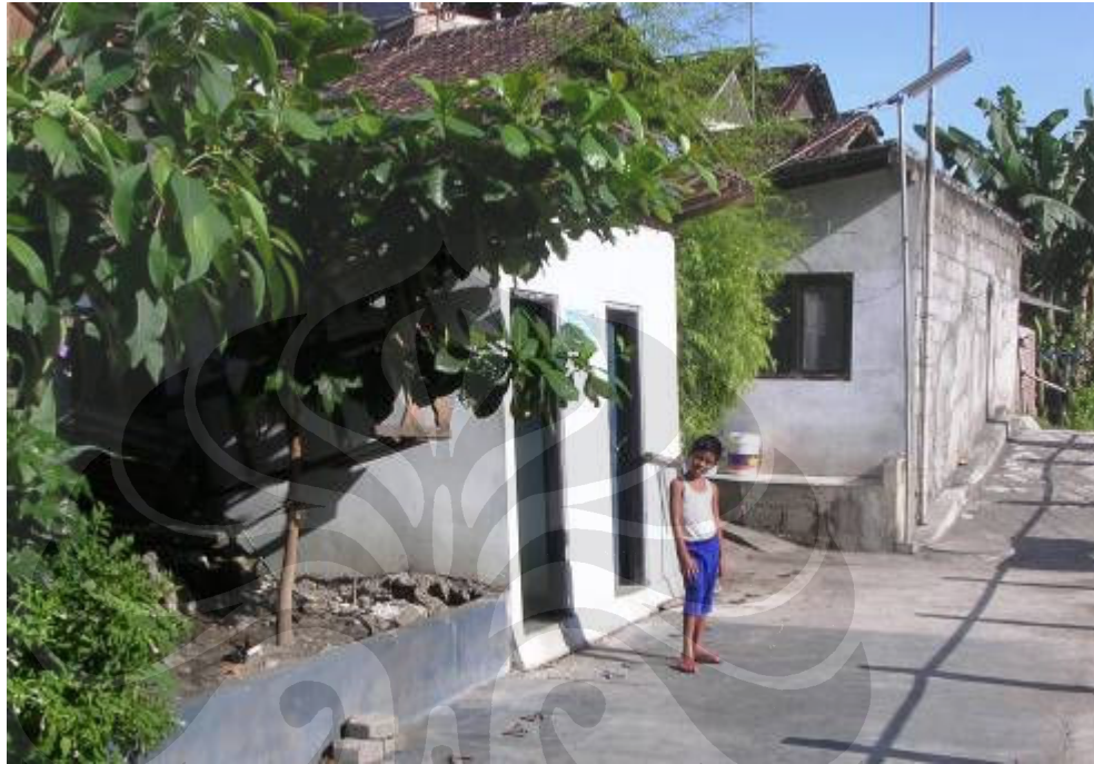
Gambar 14. MCK umum di atas bangunan IPAL komunal tahun 2008
