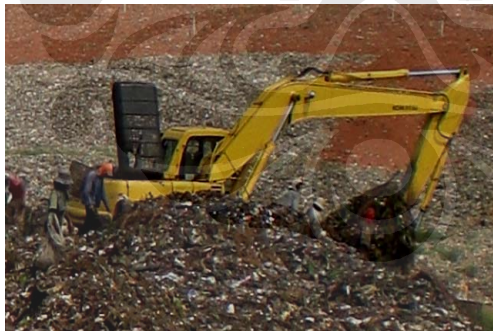
Gambar 4.9 Penyebaran Sampah dengan Backhoe
