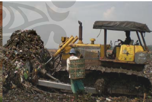
Gambar 4.10 Perataan Sampah dengan Bulldozer
