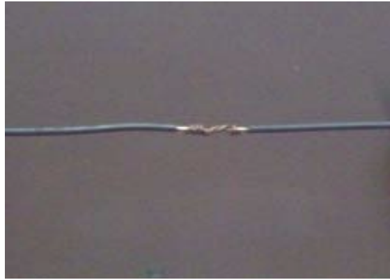
Gambar 4.3 : Sambungan Kabel sejenis Jointing 0.1
