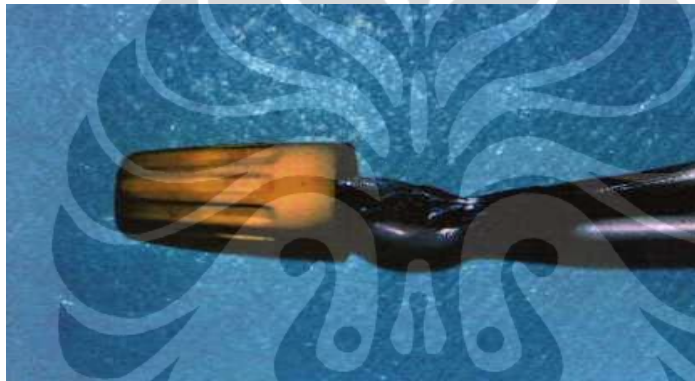
Gambar 3.4 : Sambungan Kabel menggunakan las-dop
