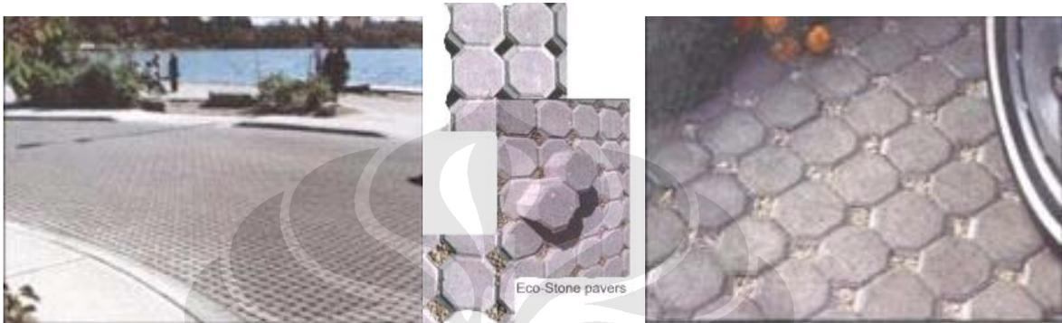
Gambar 2.28 Penerapan Teknologi *Permeable Pavement*<sup>31</sup>
