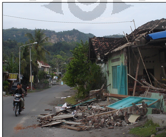
Kerusakan penduduk pada zona sesar dengan latar belakang gawir yang merupakan cermin sesar di Parang Tritis. *
