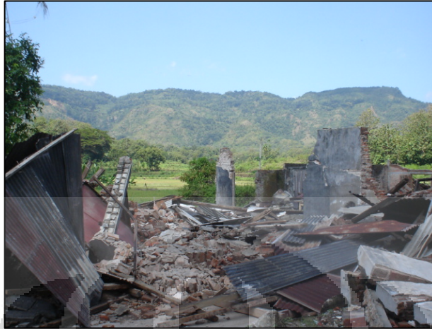
Rumah penduduk yang roboh pada zona sesar dengan latar belakang bukit segitiga facet di dusun Guyangan, desa Wonolelo, Plered, Bantul. *
