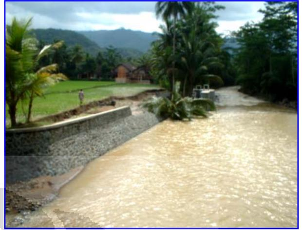
Foto 4. Kerusakan Dam Tlutak di Pintu Air
