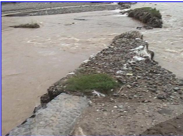
Foto 26. Kerusakan DAM Ngasem di K. Tawing
