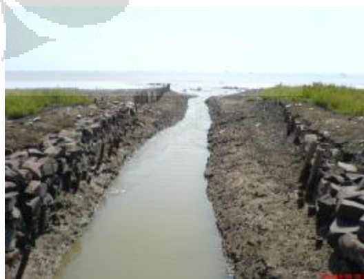
Saluran Ciantong bagian hilir
