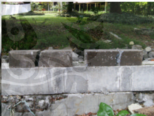
Benda uji setelah pengujian kuat lentur
