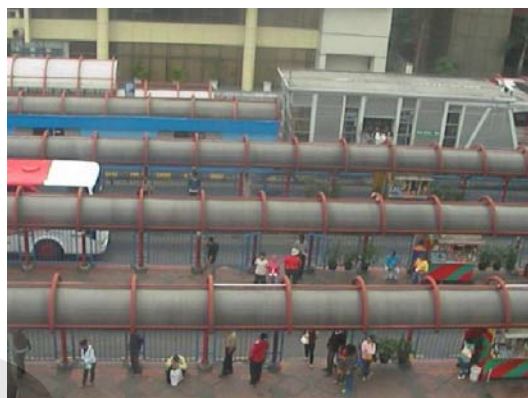
Pagar besi pembatas yang terbuka
