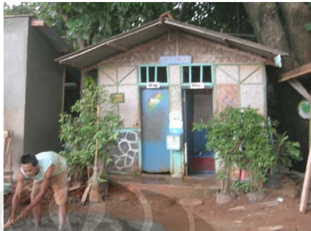
Gambar 5.3. Kondisi Kamar Mandi di sisi barat Setu Babakan
