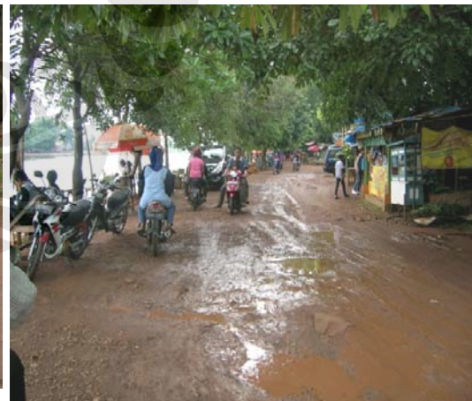
Kondisi jalan di dalam PBB yang rusak
