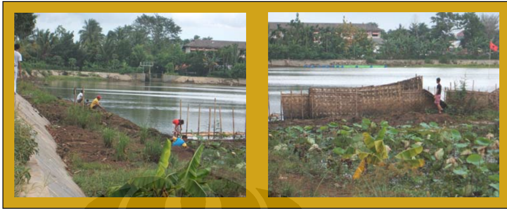
Gambar 2.4. Kondisi Situ Manggabolong
