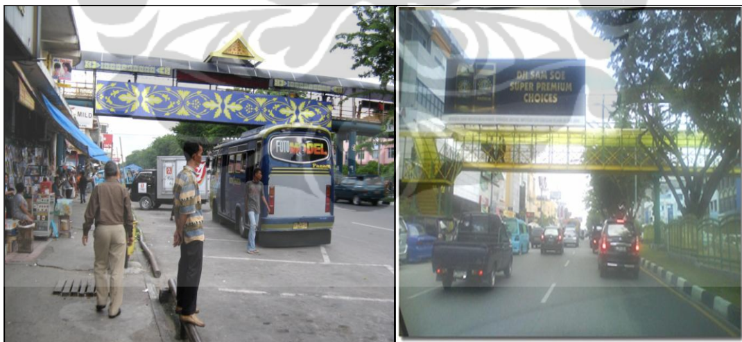
Gambar 4.19 Kondisi eksisting jembatan penyeberangan
