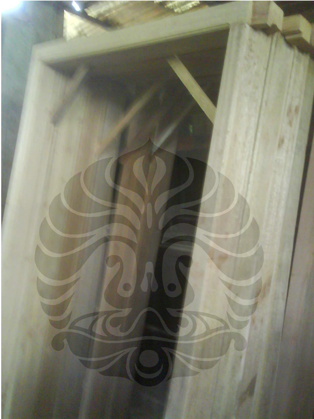
Gambar 4.2 Foto kusen tanpa ventilasi ( 1 Lubang )
