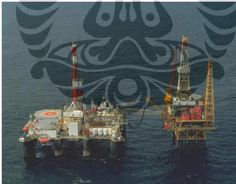
Gambar 3.14. Semi-submersible rig dengan platform jacket
