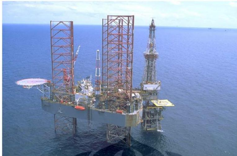
Gambar 3.13. Jackup rig dengan platform jacket
