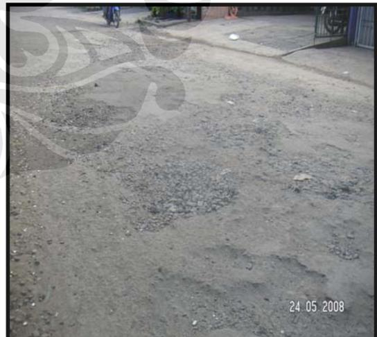
**Gambar 4.24** Kondisi perkerasan
