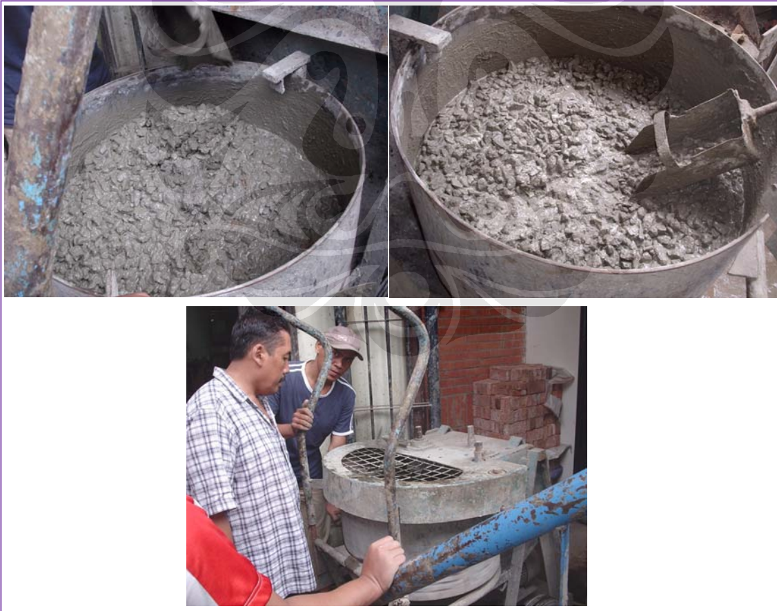
Proses Pengadukan Beton
