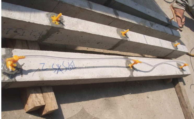
Gambar 3.4. Proses pemasangan selang tranparan yang menghubungkan titik inlet melalui packer.
