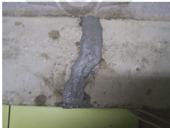
Gambar 4.5.15 . Kondisi benda uji BS-1 setelah perbaikan
