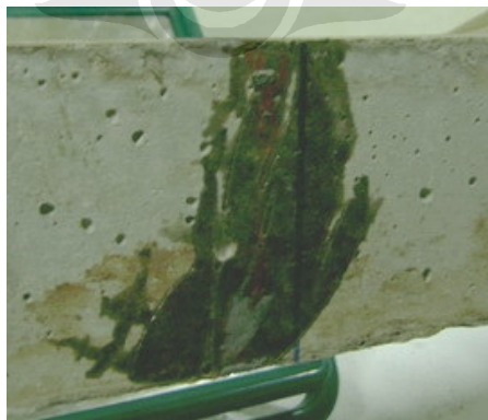
Gambar 4.5.43 Kondisi benda uji BPS-1 setelah perbaikan
