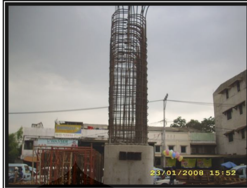
Gambar 4.8 Pemasangan tulangan kolom
