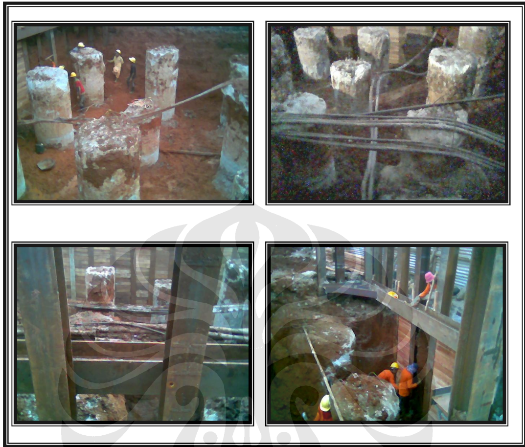
Gambar 4.4 Jaringan utilitas yang tidak dapat dipindahkan
