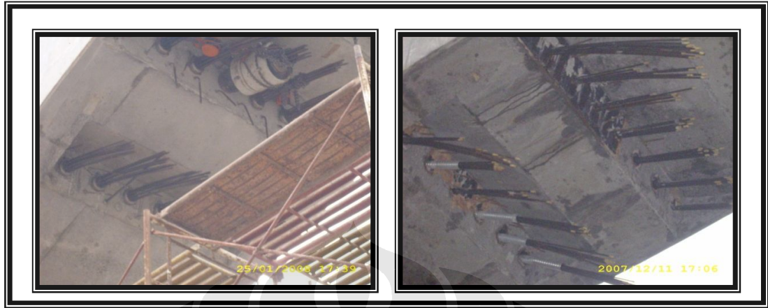
Gambar 4.10 Tendon pada PCU girder yang sudah terpasang
