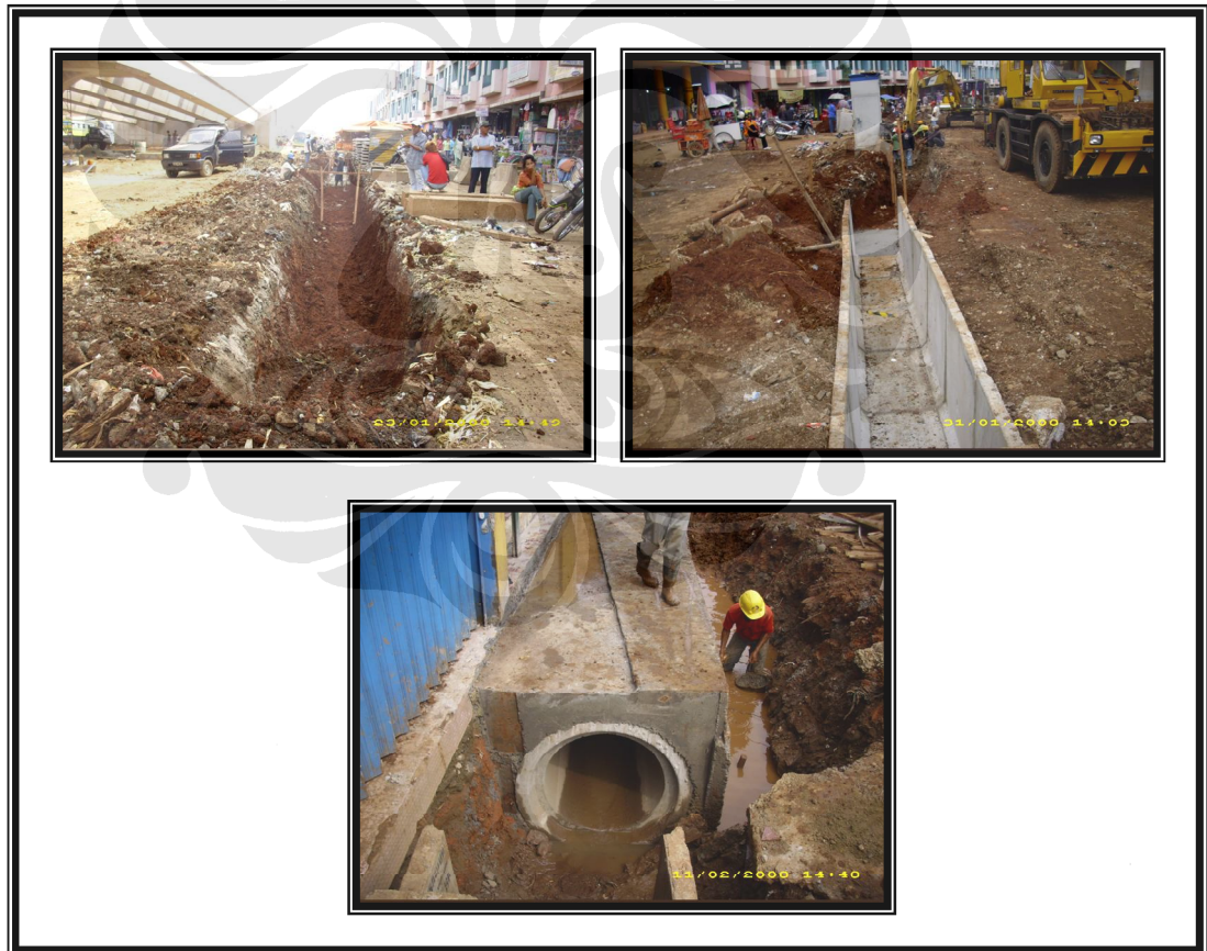
Gambar 4.9 Pembuatan saluran drainase baru
