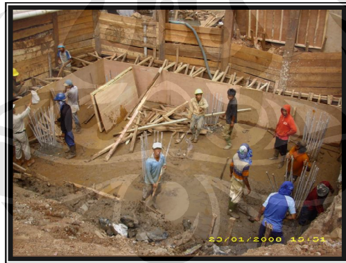
Gambar 4.2 Pembersihan area untuk persiapan pemasangan tulangan footing
