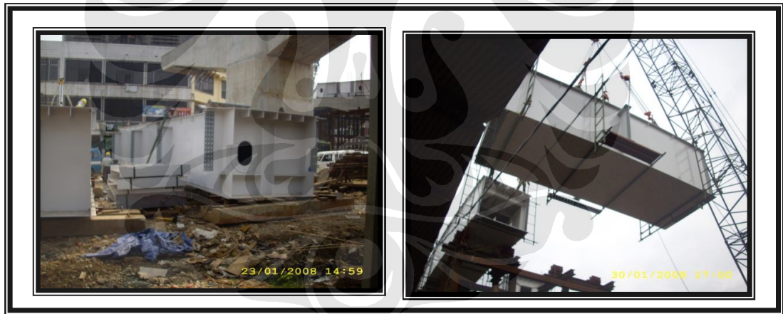
Gambar 4.11 Pemasangan steel box girder
