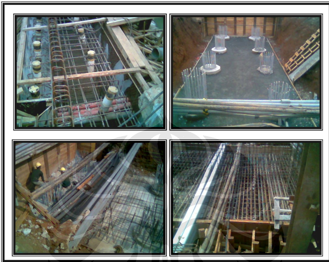
Gambar 4.6 Cable duct yang ditanam di dalam footing
