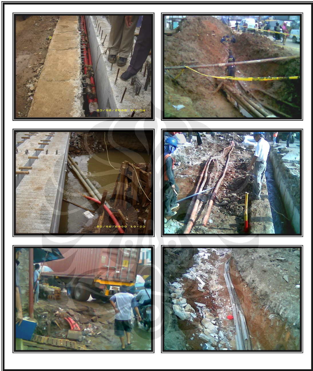
Gambar 4.3 Jaringan utilitas yang akan dipindahkan atau digeser
