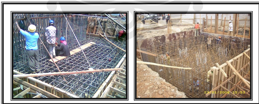
Gambar 4.7 Pemasangan tulangan footing
