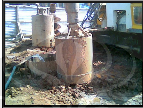
Gambar 4.1 Proses pengeboran tanah untuk pembuatan pondasi
