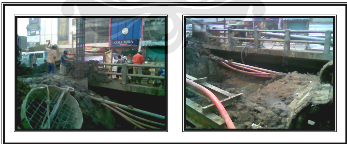
Gambar 4.5 Jaringan utilitas pada jembatan kabel
