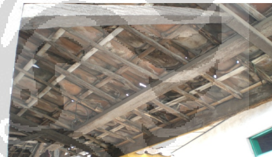
Pemanfaatan kayu mangrove untuk kontruksi rumah
