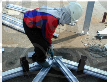
Gambar 4. 31 Penyambungan batang atas dengan batang tengah (Sumber PT. X)
