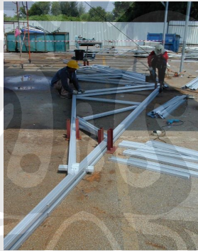
Gambar 4. 28 Penggunaan balok mal (Sumber PT. X)
