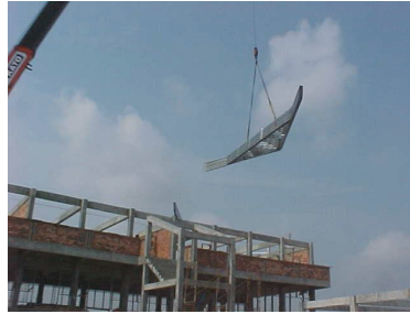
Gambar 4. 35 Pengangkatan truss ke atas bangunan dengan tower crane (untuk bangunan skala besar) (Sumber PT. X)
