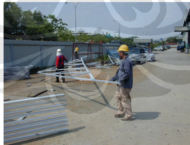
Gambar 4. 34 Penangkatan truss (Sumber PT. X)
