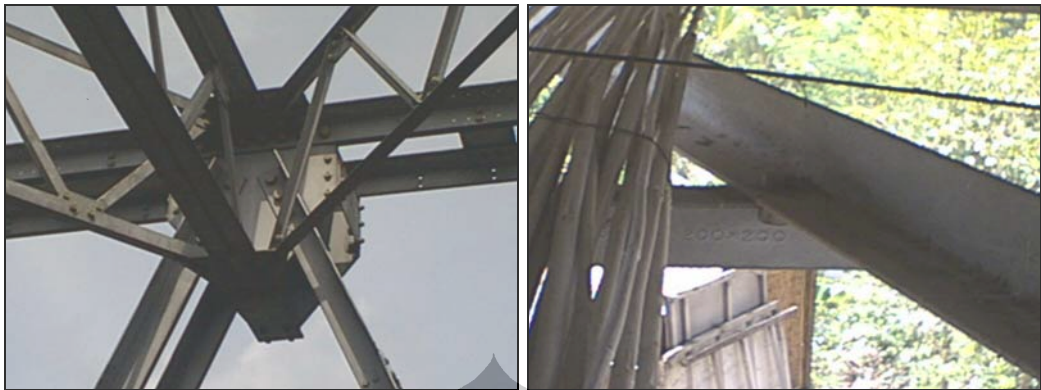
Gambar D.7. Kiri: Titik buhul atas, sambungan antara Profil I, III, 3-2, dan B. Kanan: Sambungan antar Profil 2 di bagian bawah.
