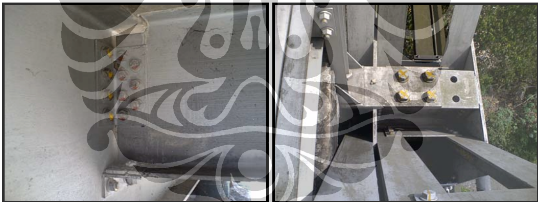
Gambar D.6. Kiri: Sambungan antara Profil 3 dengan Profil 1. Kanan: Sambungan antara Profil C dengan Profil C lain dan Profil 1.
