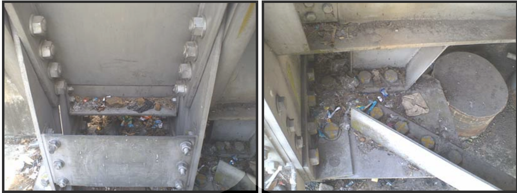
Gambar D.5. Kiri: Sambungan antara Profil A dengan Profil 1. Kanan: Sambungan antara Profil 1 dengan Profil 2.
