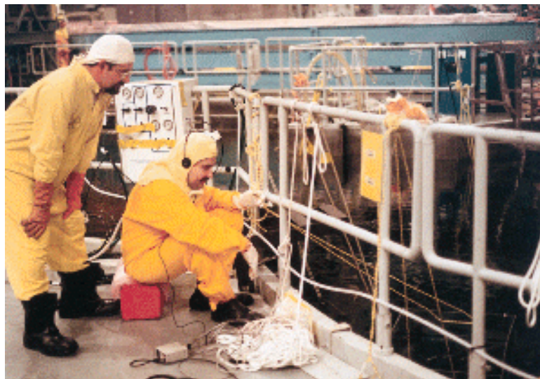
Teknisi, memakai baju protektif, melakukan inspeksi ultrasonic pada sebuah pressure vessel pada sebuah pembangkit tenaga nuklir
