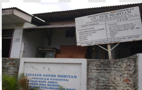
Gambar 3.4 Tampak depan PKBM Bina Mandiri
