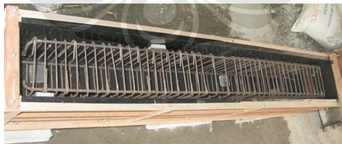
Gambar 4.9 Bekisting Balok dengan Tulangan dan Beton Tahu
