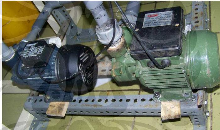
Gambar 3.4 Pompa sentrifugal
