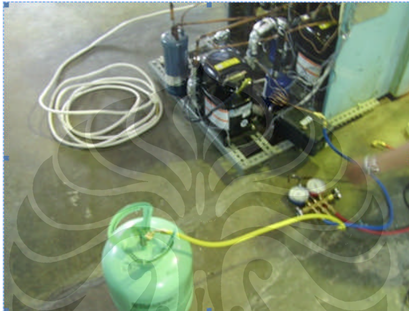
Gambar 3.19 Tes Kebocoran
