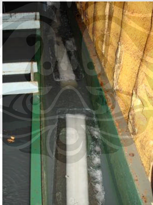
Gambar 3.8: Es balok pada sisi evaporator ice bank .
