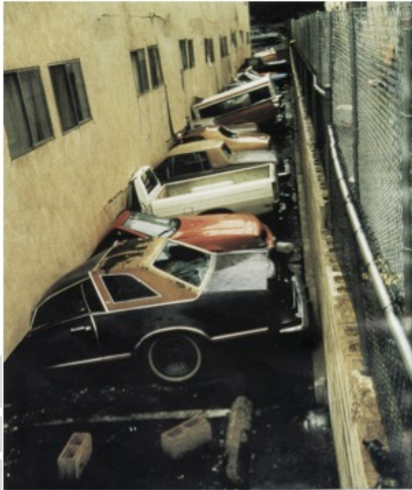
Gambar 1 Gedung apartemen runtuh menimpa mobil warga di Canoga Park, California, ketika terjadi gempa bumi Northridge, 17 Januari 1994. Gambar oleh Peter W. Weigand (Abbott, 2004)
